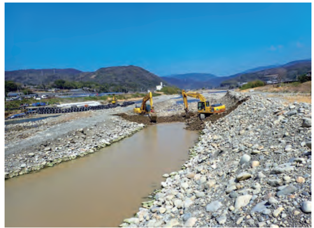
写真2. 近年多くなってきた手荒な河川工事.
